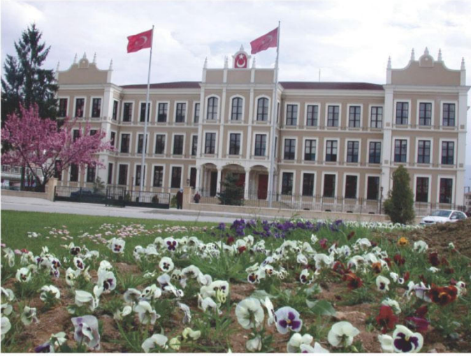
Tarihi Bolu Valilik Binası
